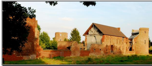
Bestandssicherung von Schloss Hambach, 1996 - 2002
