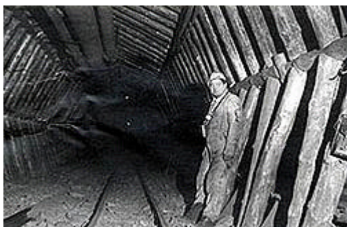
Richtstrecke mit Polygonsausbau als Verstärkung gegen starken Gebirgsdruck (1965)
