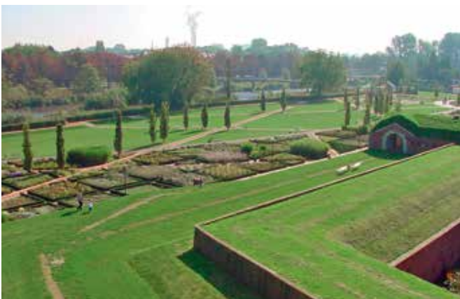
Gärten und Festungsanlage im Brückenkopf-Park Jülich
