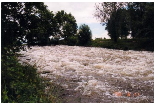
Abbildung 21: Rampe Altenburg [ELWAS NRW 2012]
