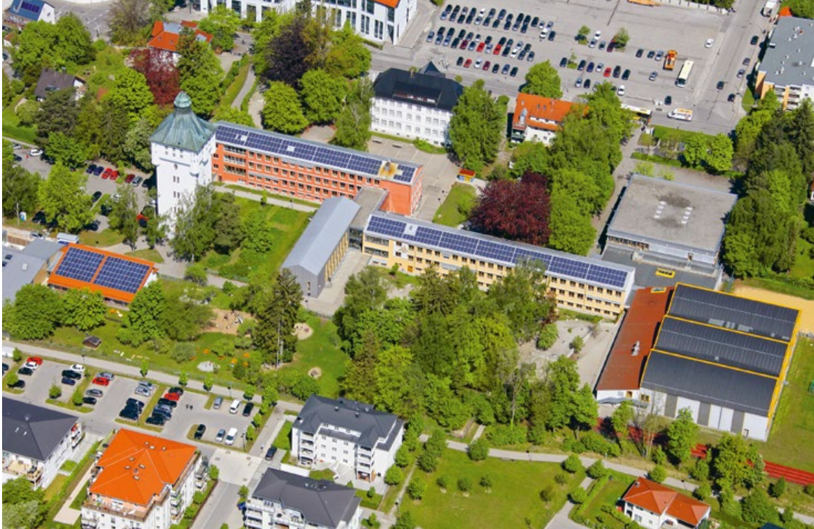
Grundschule, Wasserturm und Kinderkrippe (nach Passivhausstandard) mit Photovoltaikanlagen und Nahwärmeversorgung
