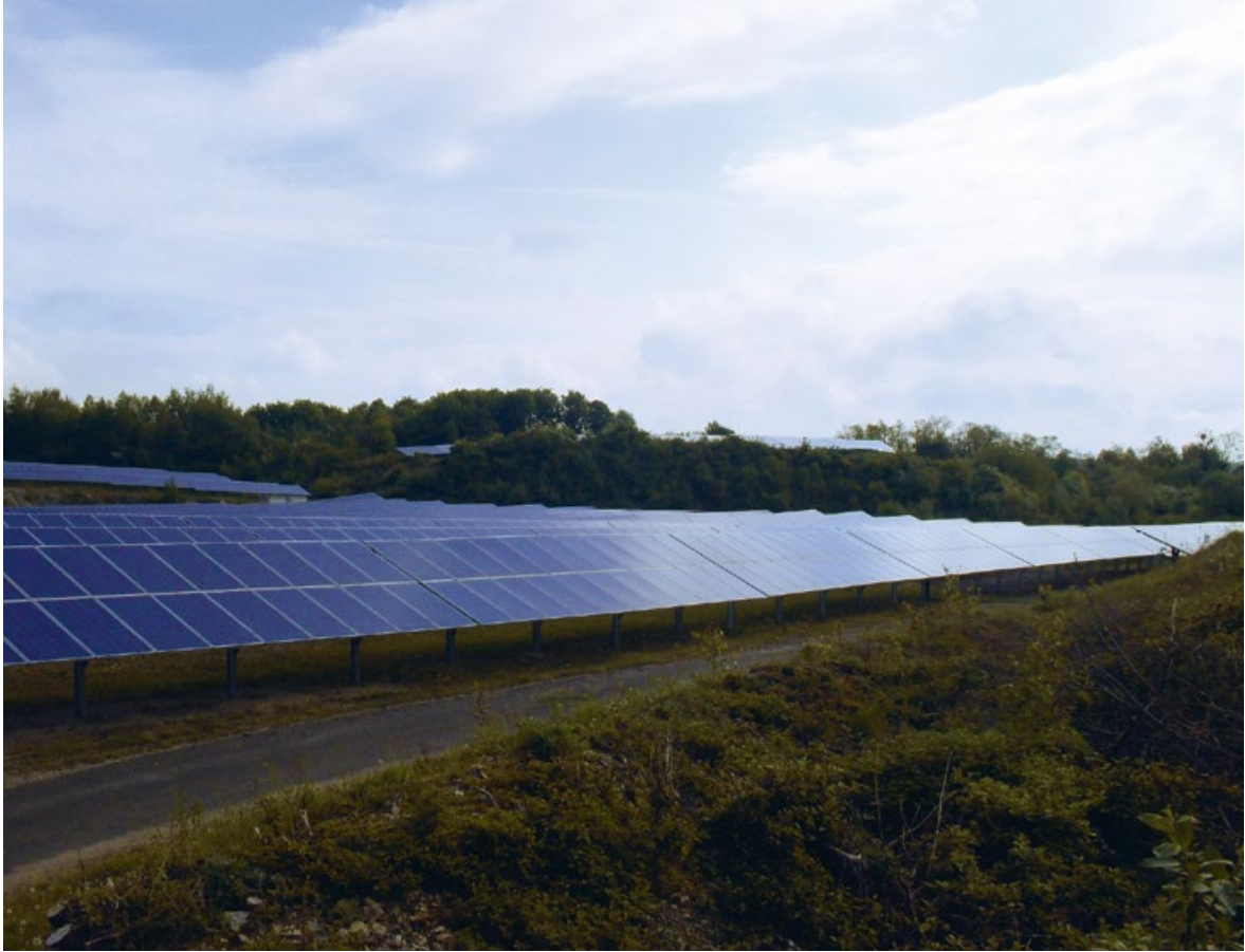
Photovoltaik-Freiflächenanlage auf dem Gelände des ehemaligen Kalkbergwerks Gersheim
