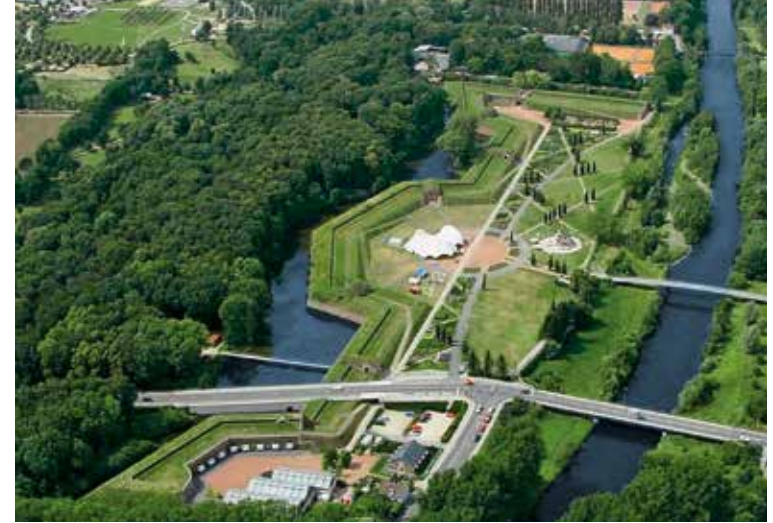
Blick aus der Luft auf den Brückenkopf-Park
