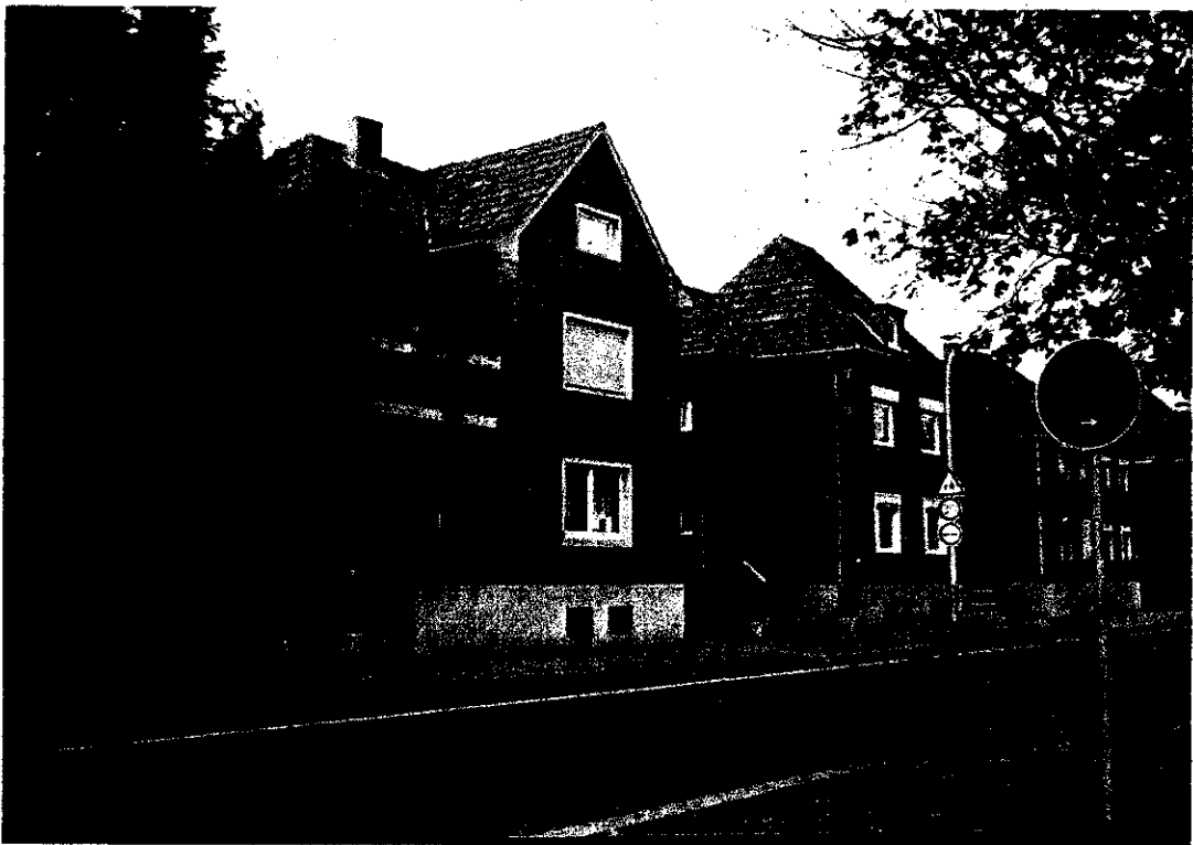
Nrn: 38 bis 32: zweigeschossig mit Sattel- und Walmdächern
