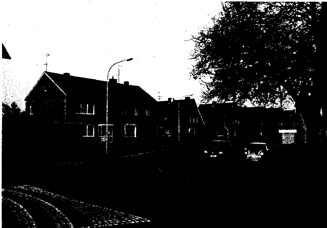
Crombachstr./Rottstr./Laachweg: eineinhalb- bis zweigeschossig mit Satteldächern
