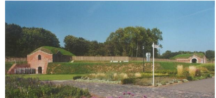
Wallanlage mit Hohltraversen
