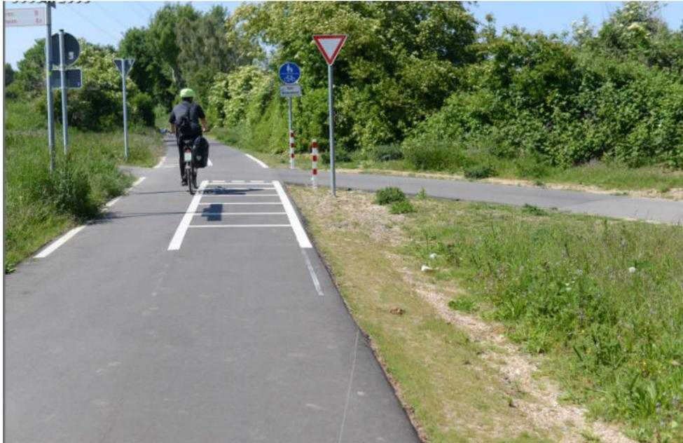
Abbildung 127: Eine überörtliche Radverkehrsverbindung ist einer lokalen Verbindung (Wohnweg) untergeordnet. Die Hierarchiefrage ist hier, wie an anderen Verflechtungspunkten zu klären
