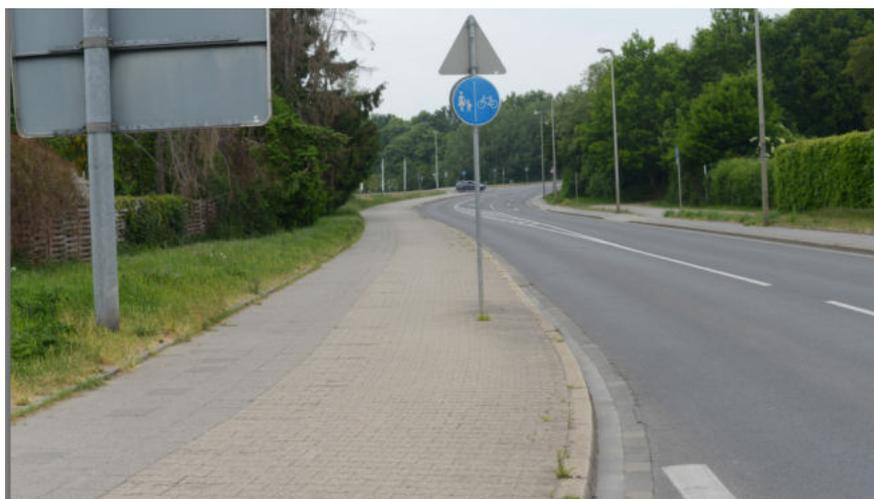
Abbildung 72: Die westliche Nebenanlage ist mit 2,30m für den Zweirichtungsradweg und 1,50m für den Fußgängerweg nicht regelkonform, kann aber so beibehalten werden, damit die querungsfreie Verbindung zwischen Mariengartenstraße und An der Leimkaul erhalten bleibt
