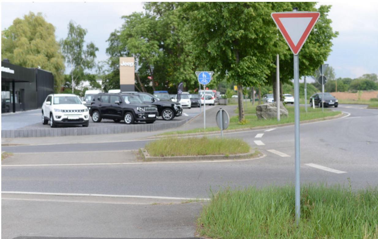
Abbildung 86: Am Kreisverkehrsplatz L 253 / Königskamp ist der Fuß- und Radverkehr dem Kfz-Verkehr untergeordnet
