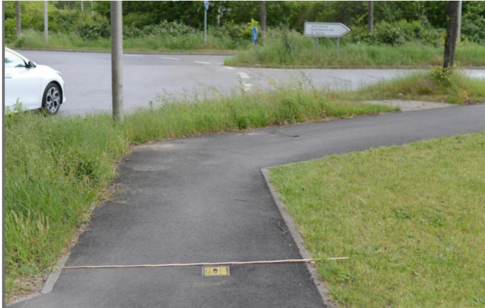
Abbildung 90: Die Breite des Weges ist mit 1,70 m statt 2,50 m unzureichend. Die Trassierung ist nicht der Fahrdynamik eines Fahrrades bei 12-20 km/h angepasst.
