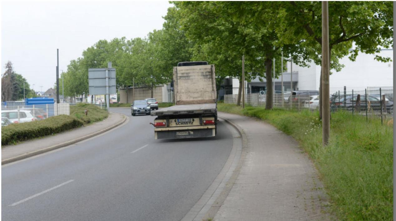
Abbildung 65: Auf dem betrachteten Abschnitt fällt beidseitig „Abstandsgrün“ jenseits der Gehwege auf. Lassen sich diese Flächen möglicherweise nutzen, um StVO-konforme Fuß- und Radwegen (Zeichen 240) mit 2,50 m Breite zu schaffen?
