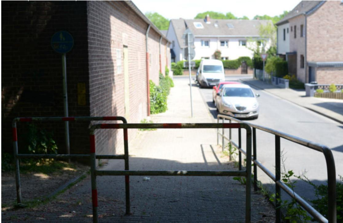
Abbildung 100: Drängelgitter an der Auffahrt zum Rurufer-Radweg
