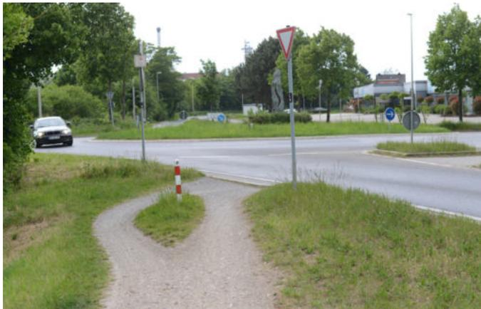
Abbildung 88: Anbindung der Wegeverbindung an den Kreisverkehrsplatz
