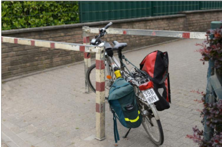
Abbildung 74: Dieses Drängelgitter ist für Kinderwagen, Fahrrad mit Anhänger oder Lastenrad ein Hindernis
