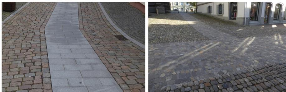
Punktuelle Oberflächenmängel stellen an einigen Stellen im Untersuchungsgebiet zusätzliche Barrieren dar. So sind insbesondere ältere gepflasterte Wege teilweise uneben, manchmal fehlen auch einzelne Steine. Punktuelle Oberflächenschäden sollten im gesamten Untersuchungsgebiet behoben werden. Im Kernbereich bleibt auf die flächenhafte Umgestaltung zu warten, die die Barrierefreiheit sicher angemessen berücksichtigen wird.
