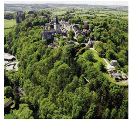
Abb. 18: Luftfoto mit Blick nach Süden auf die Spornlage der Oberstadt von Limbourg (B) an der Weser
