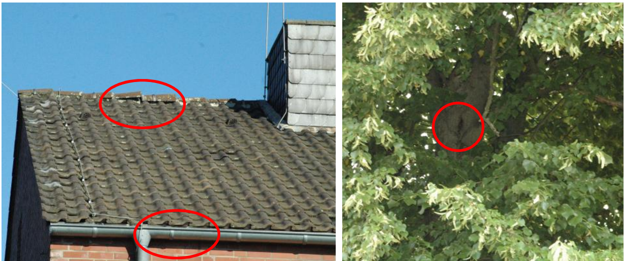
Abbildung 4: Potenzielle Quartiere von Zwergfledermaus und Großem Abendsegler an der Außenfassade des Haupthauses sowie einer angrenzenden Linde (Baumhöhle)
